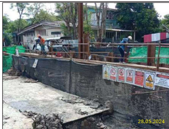
ก) การวางท่อโดยวิธีดินสอด (Boring)
