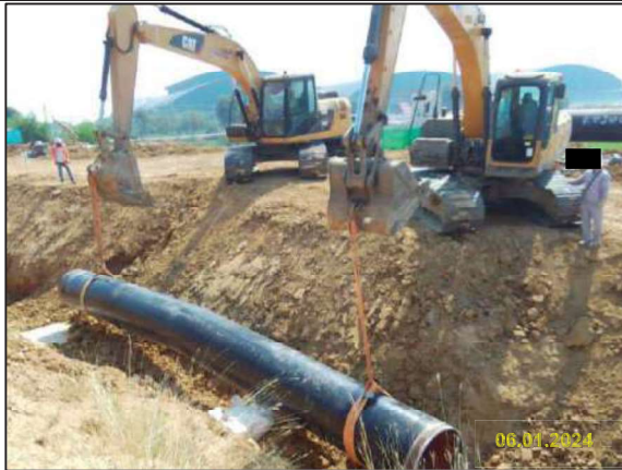
ก) การวางท่อโดยวิธีขุดเปิด (Open Cut)
