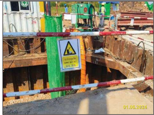
ก) การวางท่อโดยวิธีต้นลอด (Boring)
