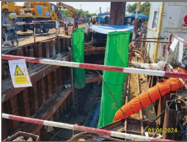
ก) การวางท่อโดยวิธีต้นลอด (Boring)
