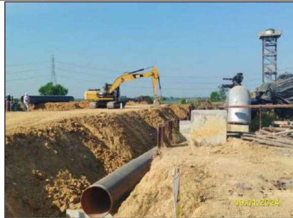
ก) การวางท่อโดยวิธีขุดเปิด (Open Cut)
